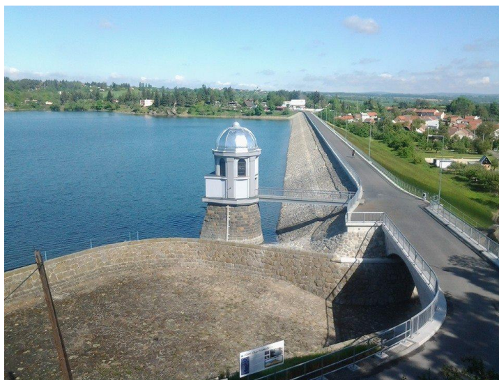
Obr. 2: Pohled na hráz, věžový objekt a bezpečnostní přeliv
