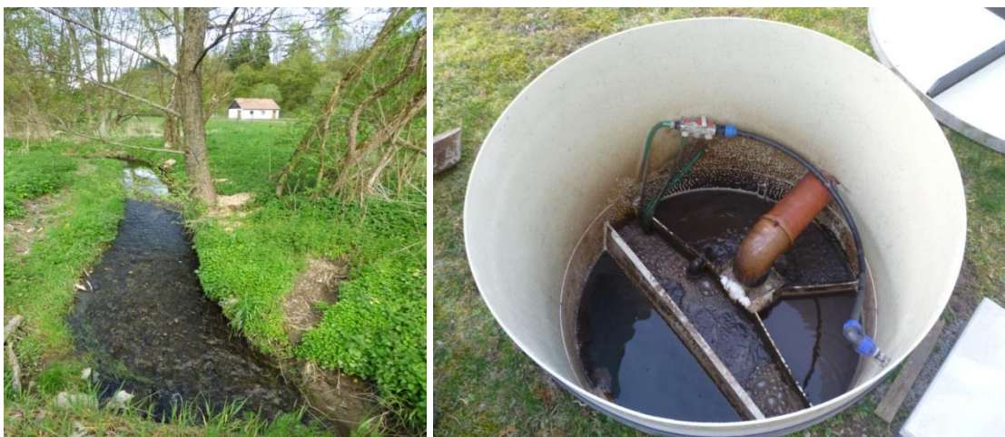
Obr. 2: Křtinský potok pod výtokem z ČOV (bílá stavba ČOV v pozadí) a těsně před propadáním do podzemí (vlevo) a systém domácí ČOV v obci Kotvrdovice (vpravo)
