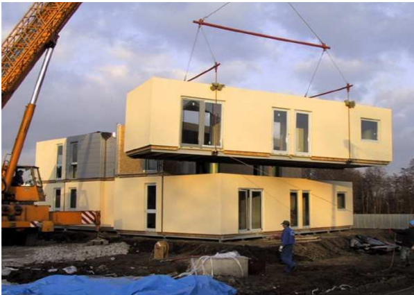
Fig. 1 Volumetric modules [8]
