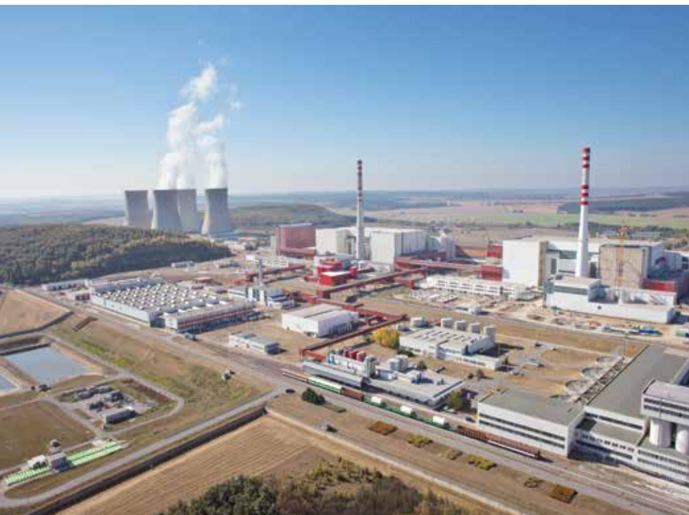
Obrázek č. 2: Jaderná elektrárna Mochovce
