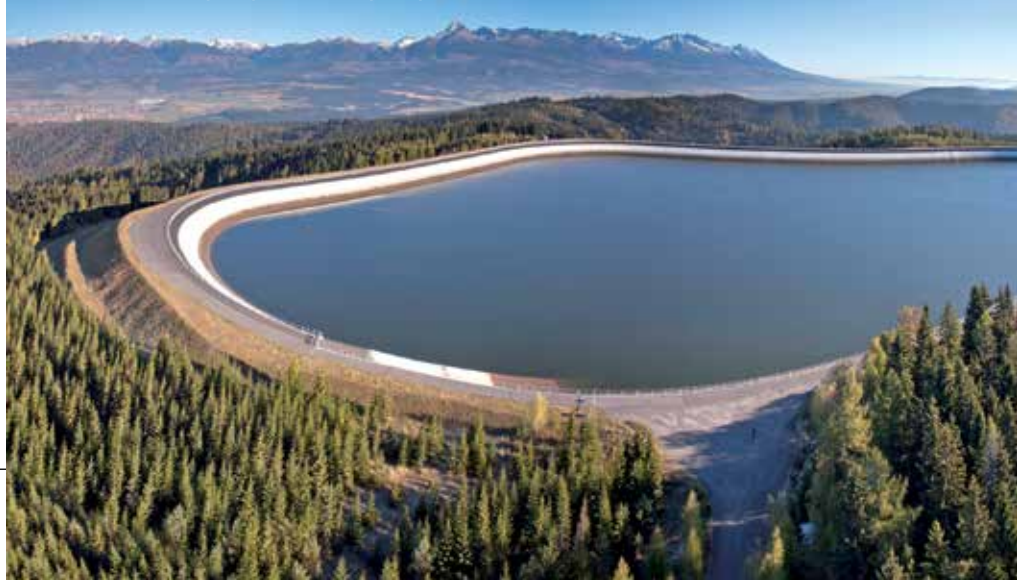
Obrázek č. 1: Horní nádrž přečerpávací elektrárny Čierny Váh
