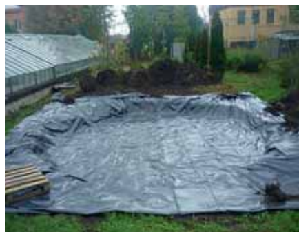
Základna o průměru 7 m s hydroizolační fólií
