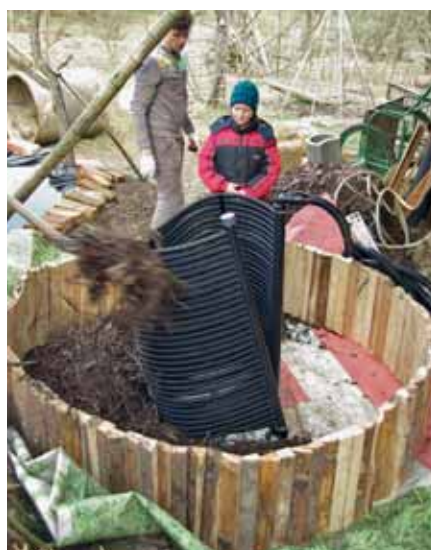
Plnění směsí s vetknutým výměníkem
