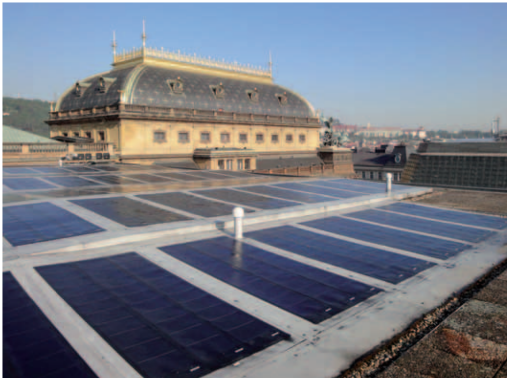
Obrázek č. 1: Fotovoltaika na střeše provozní budovy Národního divadla v Praze
