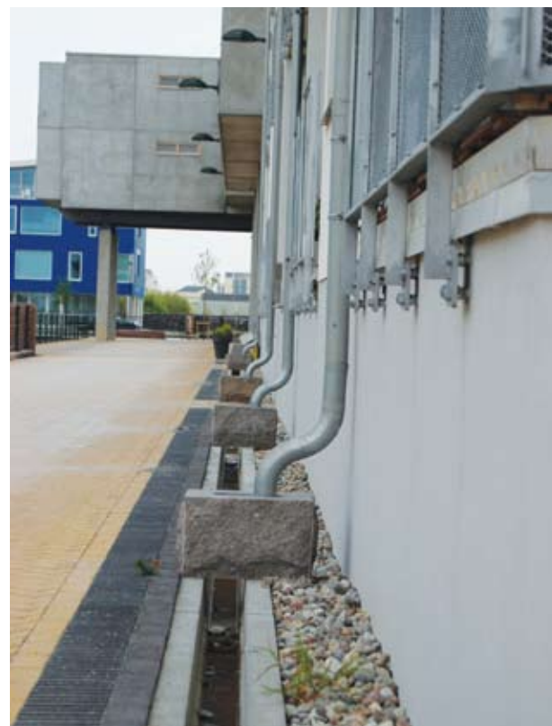
Zrážková voda sa zachytáva priamo pod zvodmi a ďalej je vedená do vsaku alebo retencie Foto: Z. Hudeková
